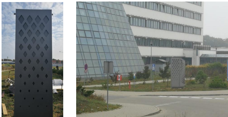
Rys. 9. Obudowa wieży fotokatalitycznej zlokalizowana na terenie UG.
