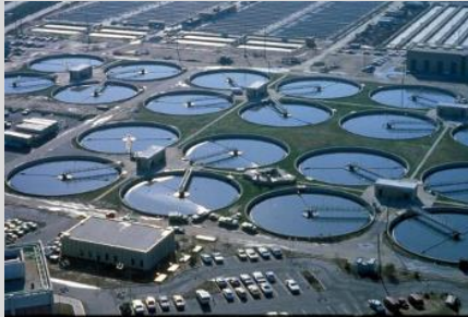
Technologie oczyszczania ścieków komunalnych i przemysłowych
